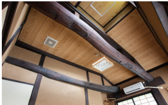
客室の天井には100年以上もこの家を守り続けている立派な梁が。
